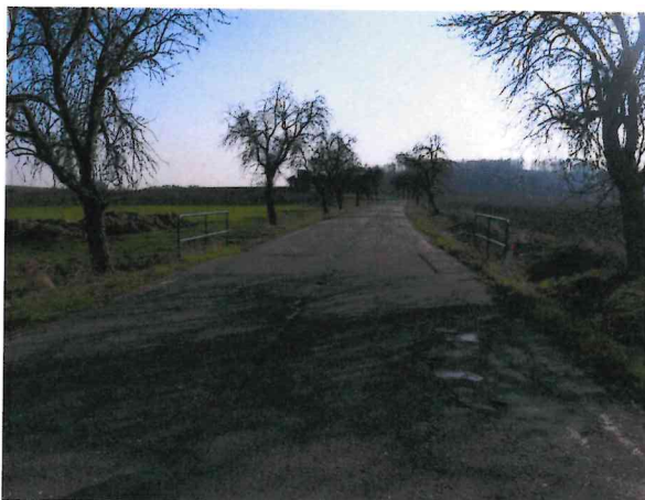
Hl. koroze, výtluky, mozaikové trhliny, vysprávkky
