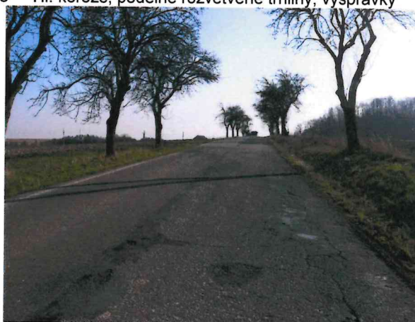
Hl. koroze, vysprávkky, podélné rozvětvené trhliny
