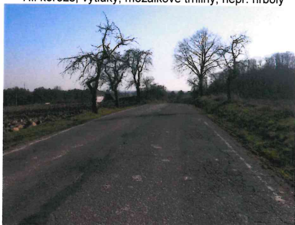
Hl. koroze, mozaikové trhliny, zvýšené nezp. krajnice
