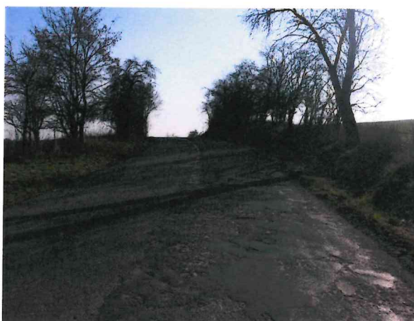
Hl. koroze, mozaikové trhliny, deformace, vysprávký
