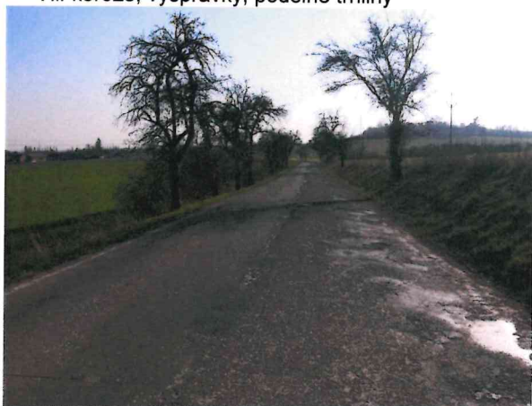
Hl. koroze, plošná deformace, výtluky, mozaik. trhliny
