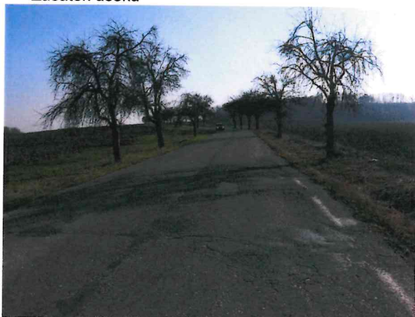
Hl. koroze, mozaikové trhliny až síťové trhliny, deformace
