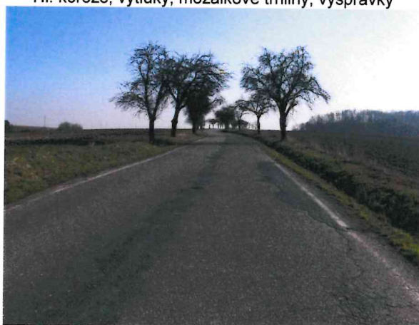
Hl. koroze, podélné rozvětvené trhliny, vysprávkky
