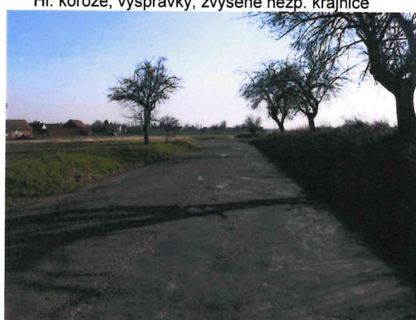
Hl. koroze, vysprávký, výtluky, nepravidelné hrboly
