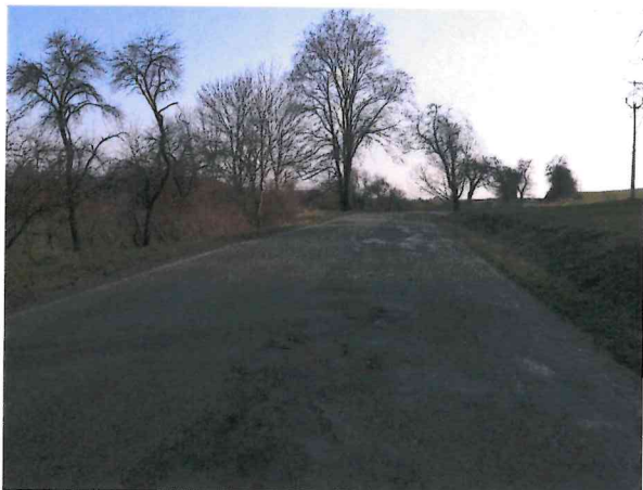
Hl. koroze, vysprávký, podélné trhliny
