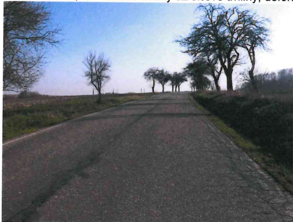
Hl. koroze, výtluky, mozaikové trhliny, nepr. hrboły
